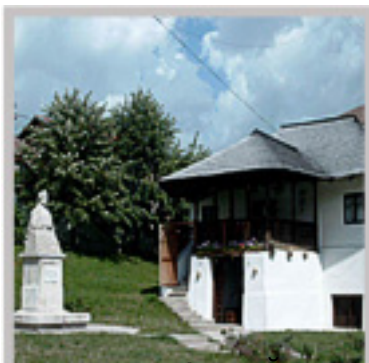
Obiectiv cultural: Biserica de lemn din satul Măleș, județul Mureș, construit în 1836, din lemn, cu o lăungime de 12,6 m, lărgime de 4,0 m și o înălțime de 10,5 m.
